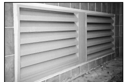
Príklad osadenia akustických žalúzií priamo do fasády.
