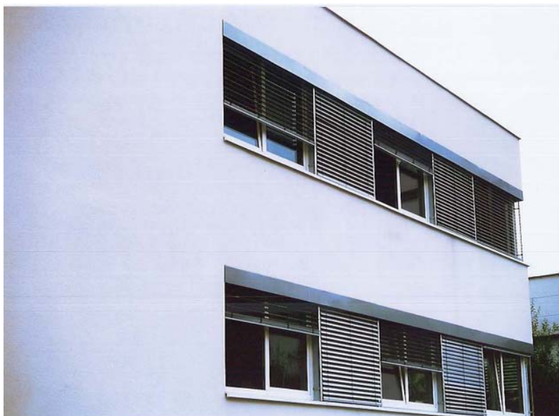
Administratívna budova Bratislava
