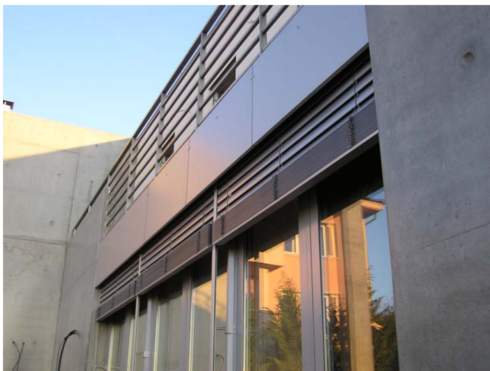
Rodinný dom Staré Grunty
